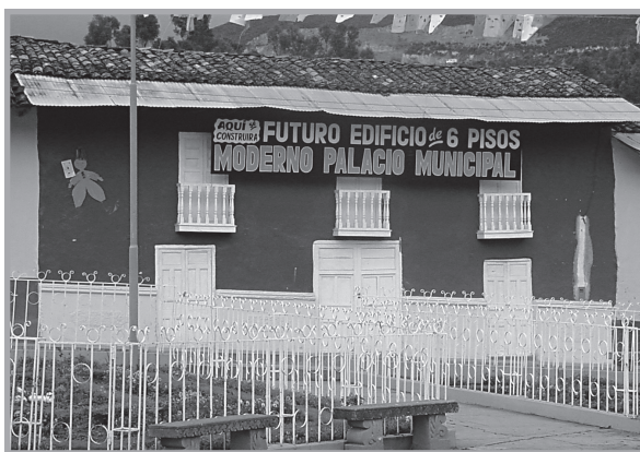
Encañada. ¿Hacía falta de verdad una obra como la anunciada?
