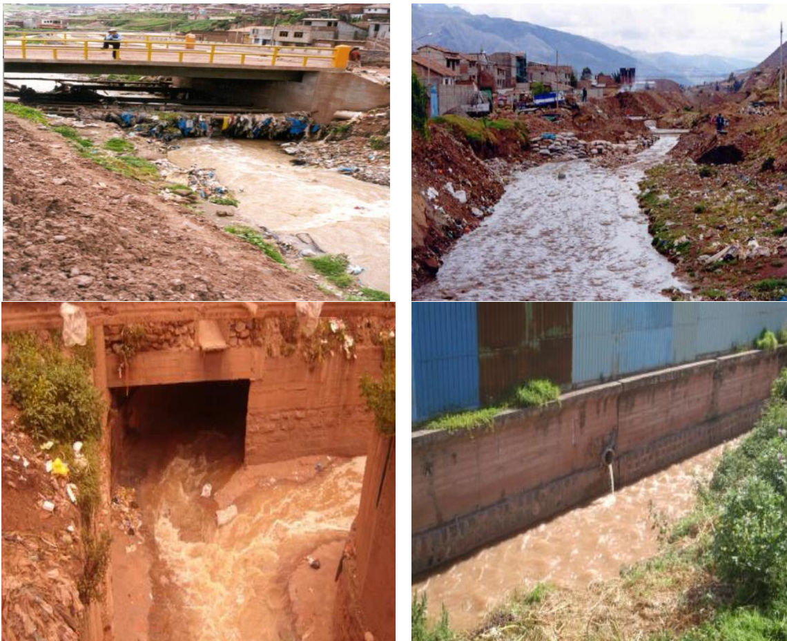
Figura A1.1: Contaminación del Río Huatanay
